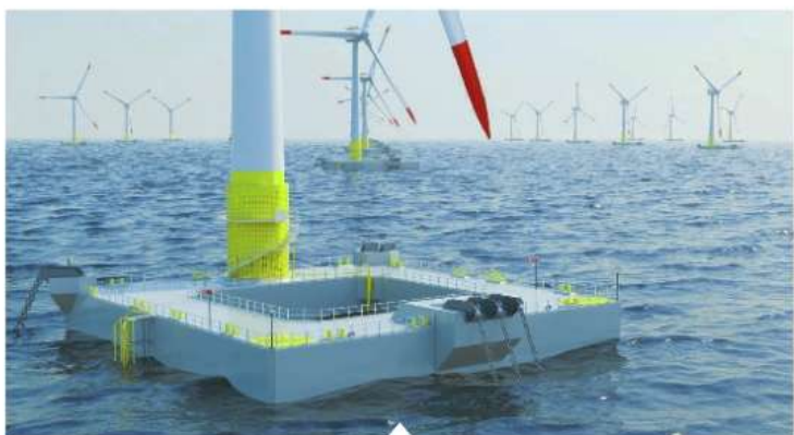
L'éolienne Floatgen affiche une puissance de 2 MW (vue d'artiste).
